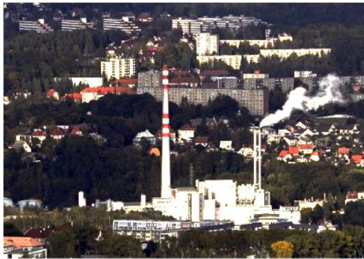
Instalacja w Libercu (Czechy)
